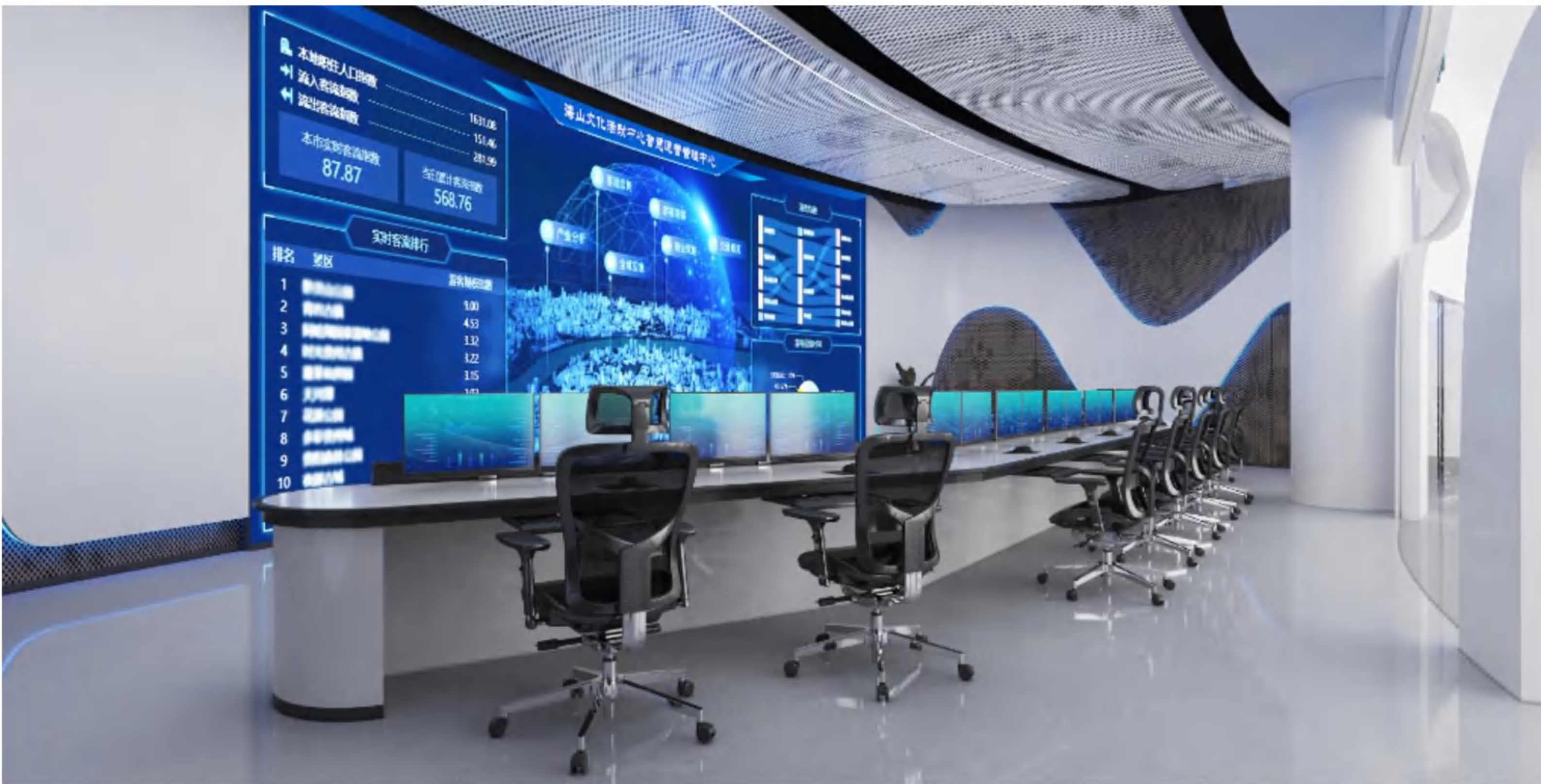
智慧管控中心
