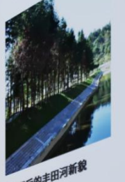
治理后的丰田河新貌
